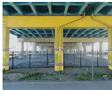
Estacionamiento/ Acceso a caminos
