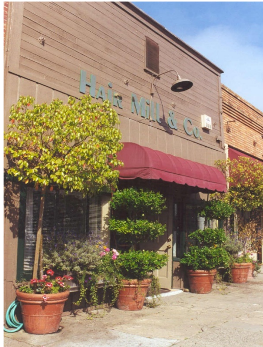
Thompson Folger Building
